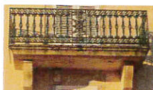
Balcon - XIXe Garde-corps en fonte
